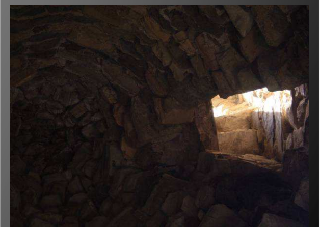
Atalaya, cerramiento y acceso al segundo piso
